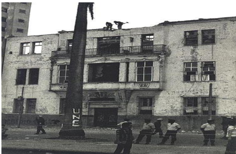
Figura 1: Prédio da UNE sendo incendiado. (ACERVO INFOGLOBO)
