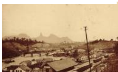
Figura 2- Visão geral da Estação Ferroviária
