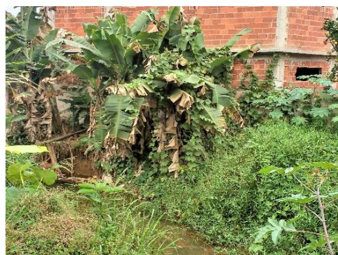
ILUSTRAÇÃO 15 – Edificação nas margens do córrego
