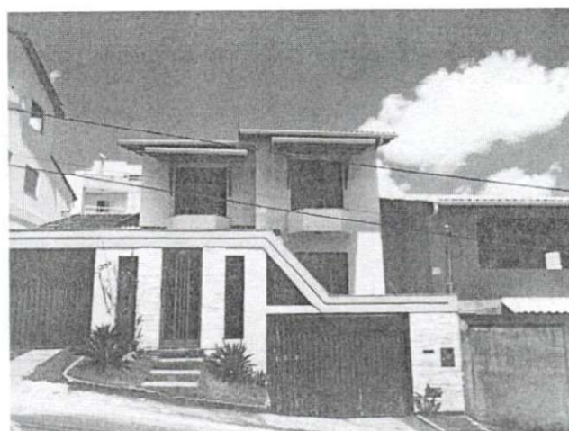
Foto 9 – Moradia no Bairro Alfa Sul, Manhuaçu – MG.
