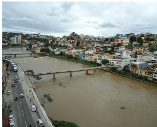
Ilustração 06: Situação atual no entorno do Rio Itapemirim. Atenção para as ocupações irregulares próximas ao rio.
