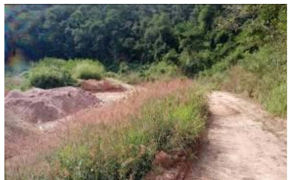
FIGURA 24 – Loteamento em processo de abertura de vias
