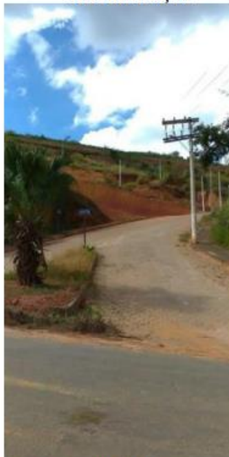
FIGURA 34 – Via principal Bairro Cidade Nova, falta de arborização
