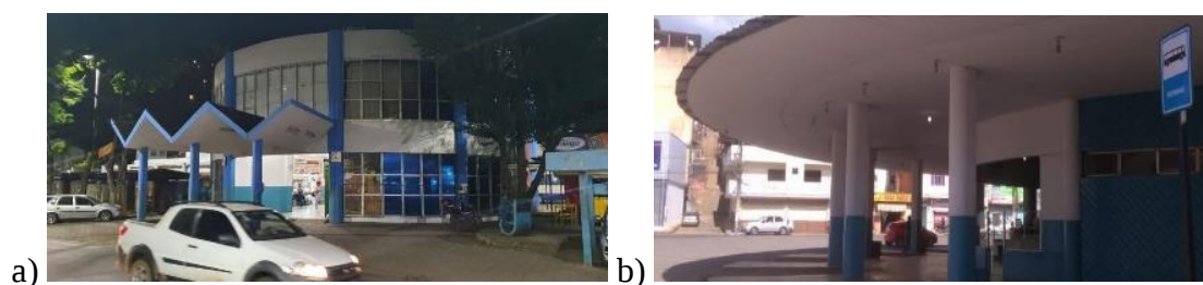
FIGURA 13 - Rodoviária de Manhuaçu -MG fachada frontal (a) e posterior (b)
