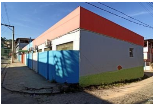
ILUSTRAÇÃO 29 - Lateral da escola com ausência total da calçada
