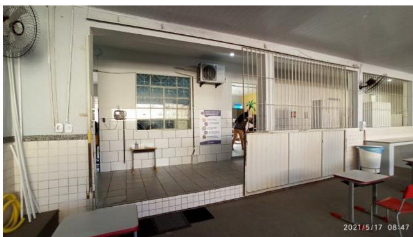
ILUSTRAÇÃO 32 – Desnível da circulação para o pátio coberto
