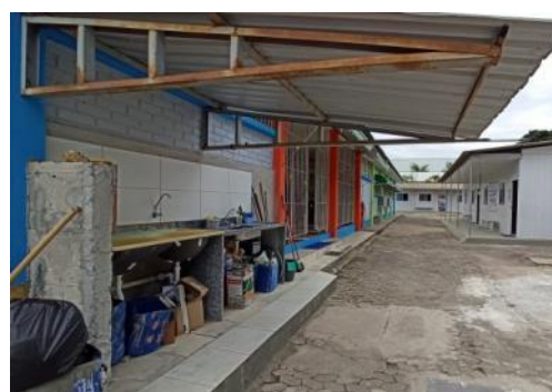
ILUSTRAÇÃO 22 – Desníveis entre setores internos e externos
