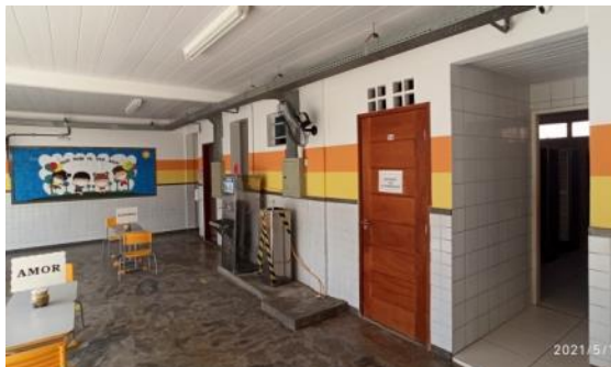
ILUSTRAÇÃO 23 – Banheiro para PCD com desnível na porta
