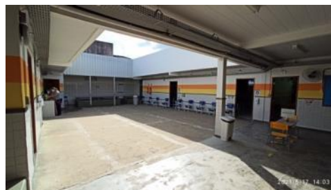
ILUSTRAÇÃO 37 – Pátio coberto e pátio descoberto
