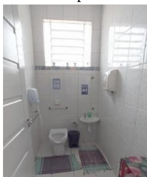
ILUSTRAÇÃO 21 – Banheiro para PCD
