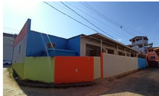
ILUSTRAÇÃO 06 – Fachada posterior da EMEB Oswaldo Machado
