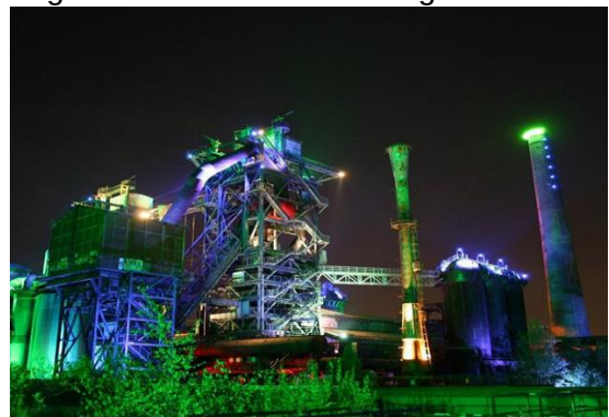
Figura 23: Estrutura do antigo alto-forno
