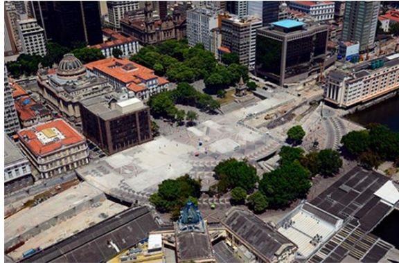
Figura 05: Elevado da Perimetral
