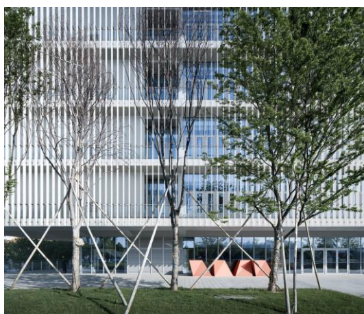
Figura 4 – Perfis metálicos da fachada
