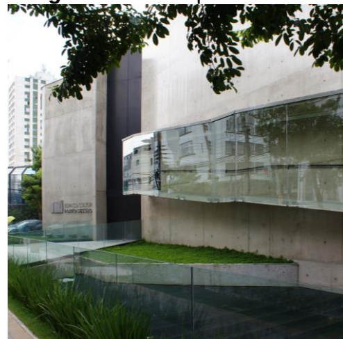
Figura 11 – Rampa em anexo
