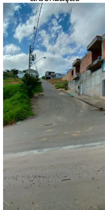
FIGURA 35 – Via principal Bairro Vale Verde, falta de arborização
