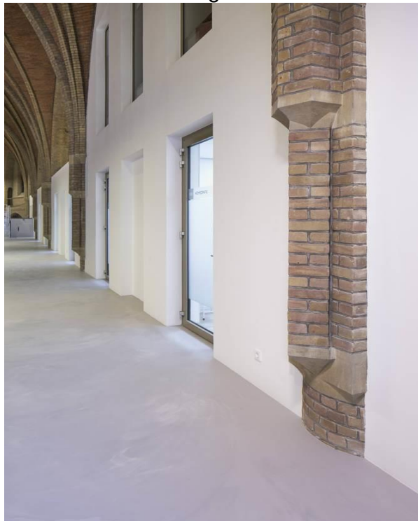
Figura 12 - Detalhes feitos nas paredes de poliestireno que imitam a arquitetura do edifício original
