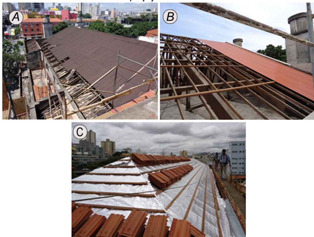
FIGURA 16. Reforma do telhado. A) Telhado em estado avançado precário de conservação. B) Recuperação da estrutura do telhado existente. C) Telhado cerâmico, executado nas antigas áreas sobre o palco e sala de projeção
