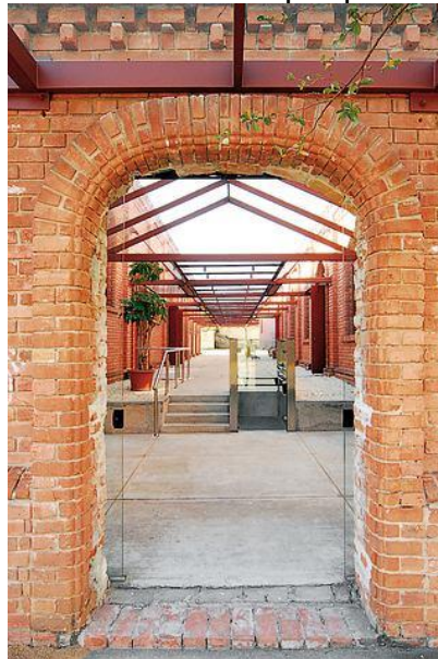
FIGURA 23. No acesso, os antigos portões, que impediam a vista do interior do conjunto, foram substituídos por portas envidraçadas
