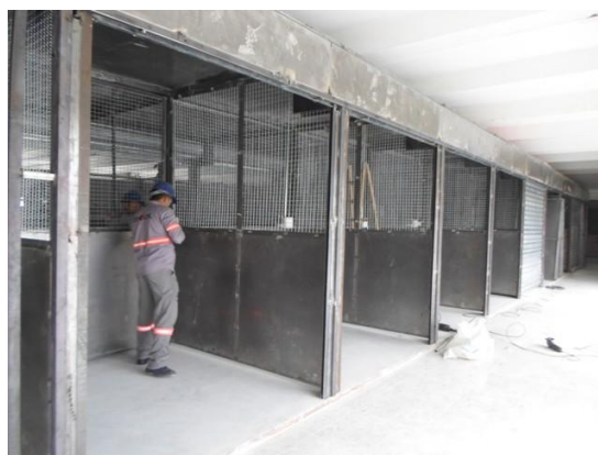
FIGURA 18. Montagem das lojas em estrutura de metalon
