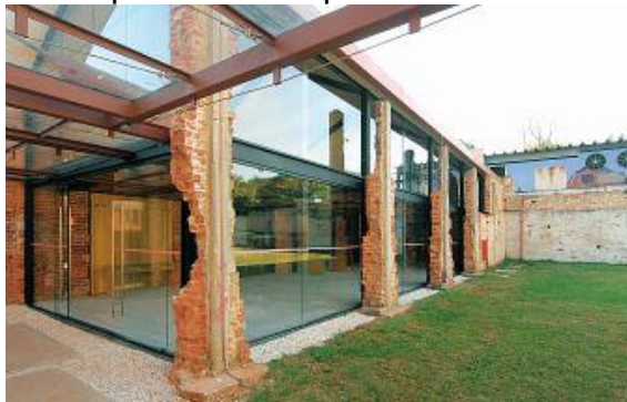
FIGURA 22. No anexo, as quase-ruínas da parede lateral, estabilizadas, mantiveram o aspecto com o qual foram encontradas
