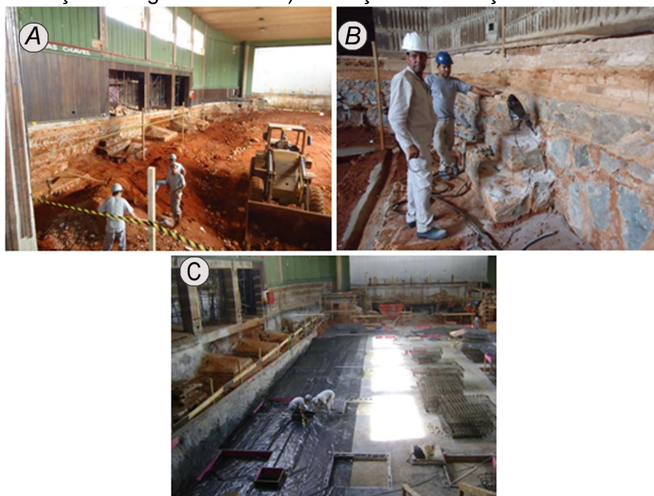
FIGURA 13. Reforma da estrutura. A) Rebaixamento do piso original. B) Reforço nas fundações antigas através. C) Execução de fundação no sistema Radie.
