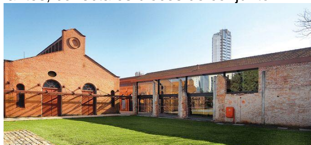
FIGURA 24. A cobertura envidraçada plana, fixada nas paredes com a ajuda de tirantes, conecta os blocos do conjunto.
