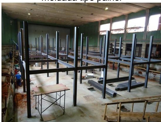
FIGURA 14. Sistema de construção mista com pilares e vigamentos em perfis metálicos com pisos em laje pré-moldada tipo painel
