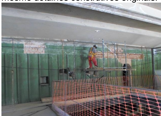
FIGURA 17. Recuperação do revestimento original mantendo os mesmo detalhes construtivos originais.
