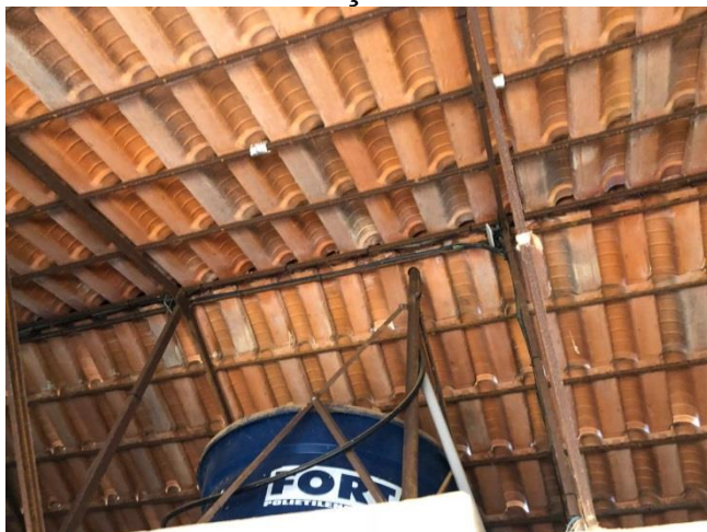
Figura 15. Cobertura em telha colonial e aço.
