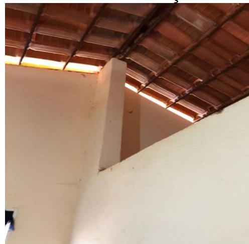
Figura 16. Cobertura em telha colonial e aço.
