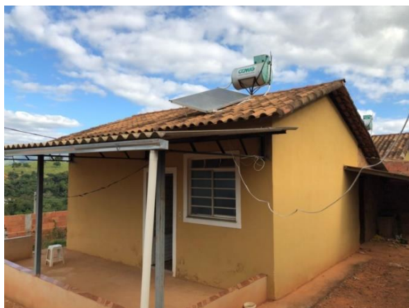
Figura 6. Instalação dos aquecedores solar
