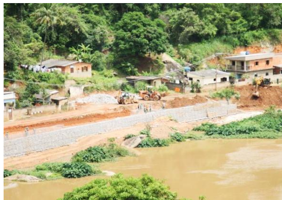
FIGURA 4 – Muro de contenção no Rio Piabanha
