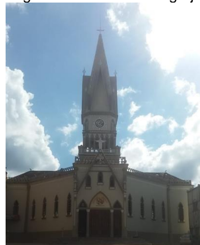
Figura 14: Fachada da Igreja
