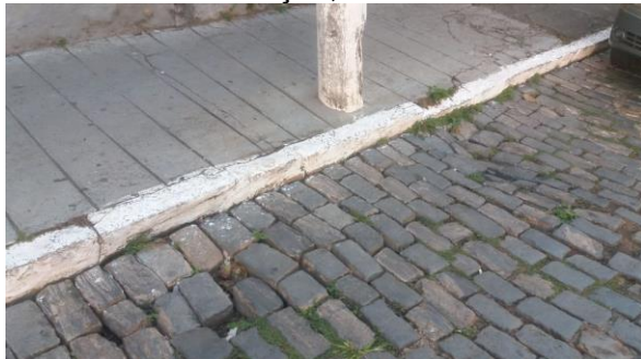
Figura 12: Pavimentação com baixa manutenção, 2019
