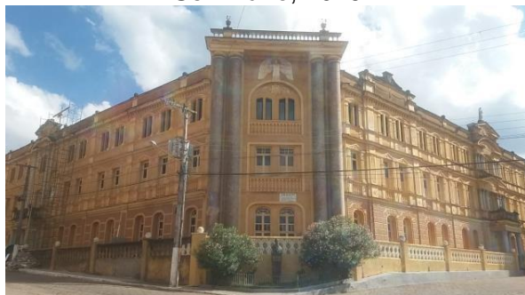
Figura 16: Fachada Perspectiva do Seminário, 2019
