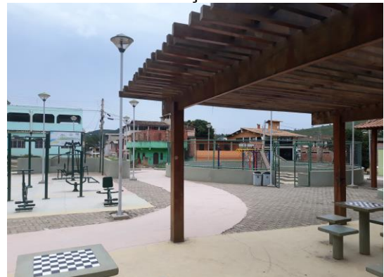
FIGURA 10 – Vista do Interior da Praça
