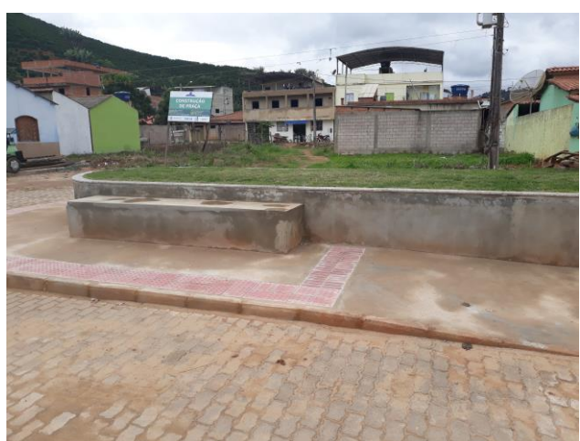
FIGURA 22 – Vista do Banco de Concreto
