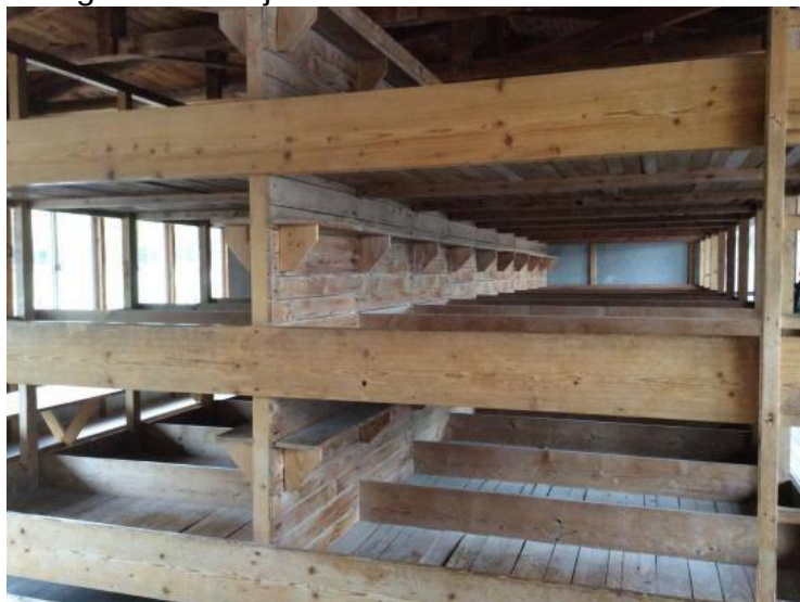
Figura 1 – Alojamento em Dachau - Alemanha.
