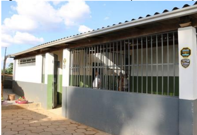
Figura 11: Fachada Canil Municipal de Manhuaçu
