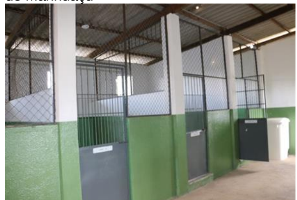
Figura 15: Baias para cães do canil municipal de Manhauçu
