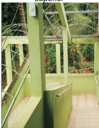
Figura 19 Rampa de acesso ao pavimento superior
