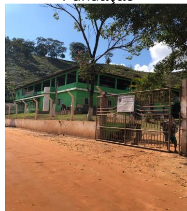
Figura 23 Fachada da Fundação
