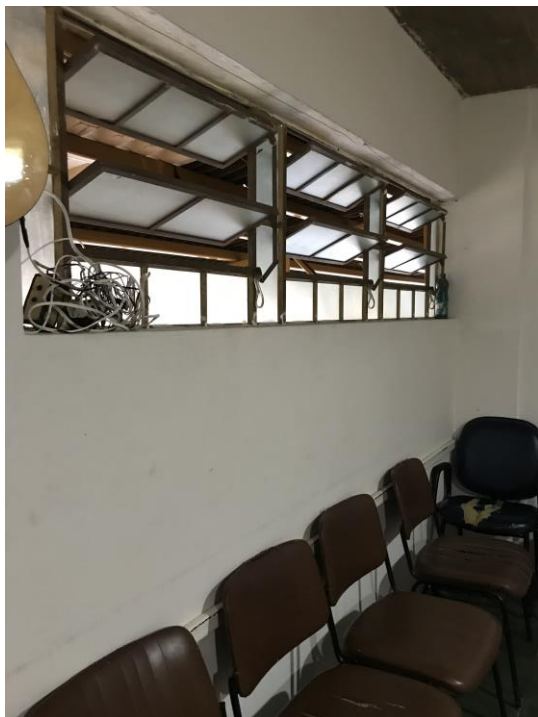
Figura 9: Abertura da janela em bscula de proporcionando pouca iluminao e ventilao para o ambiente de sala de aula
