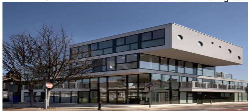
FIGURA 16 – Fachada do centro comunitário na Inglaterra
