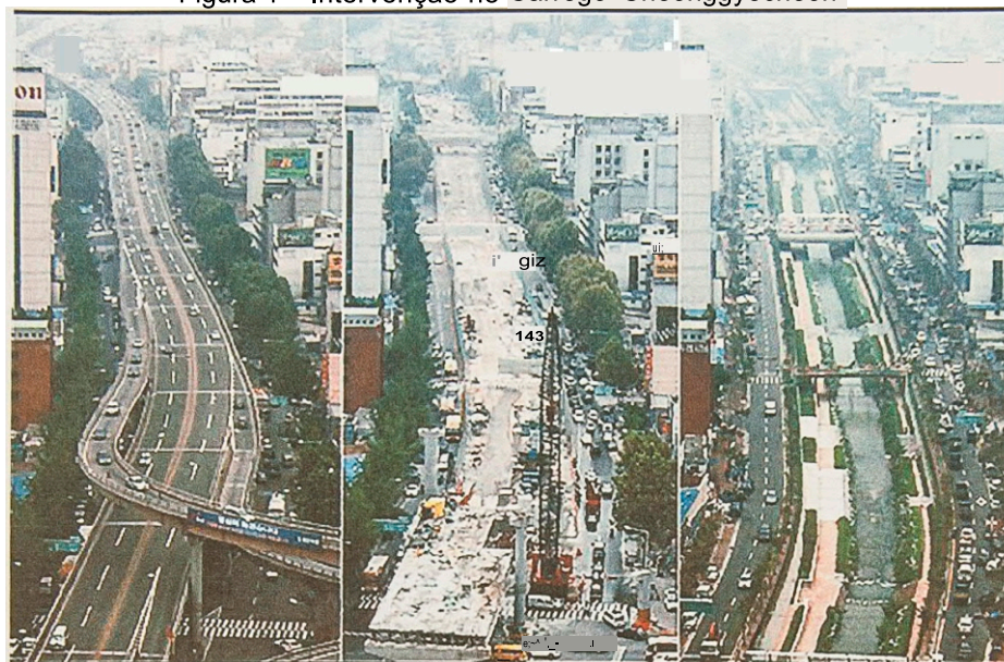
Figura 1 - Intervenção no Carrego Cheonggyecheon
