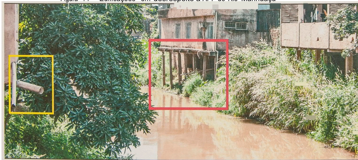
Figura 14 - Edificações em desrespeito à APP do Rio Manhuaçu
