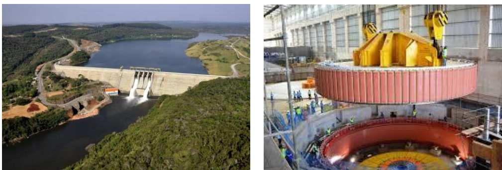
FIGURA1 - Geradores e Reservatórios
