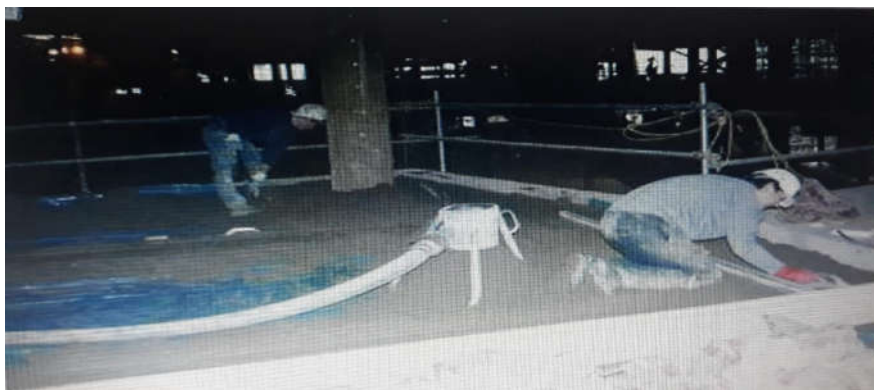
FIGURA 2 – Modelo de Bombeamento de Argamassa
