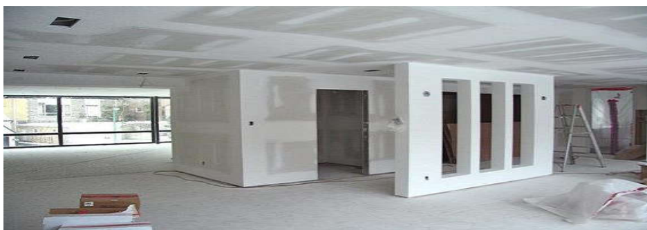
FIGURA 4 – Divisórias de Gesso Cartonado
