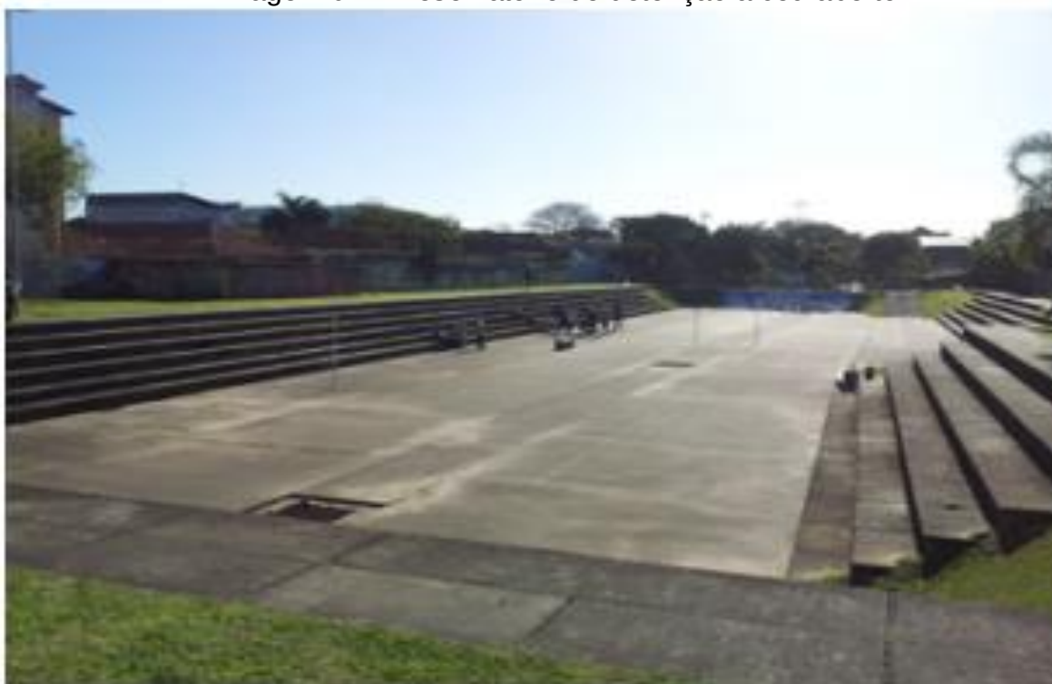
Imagem 04 – Reservatório de detenção à céu aberto
