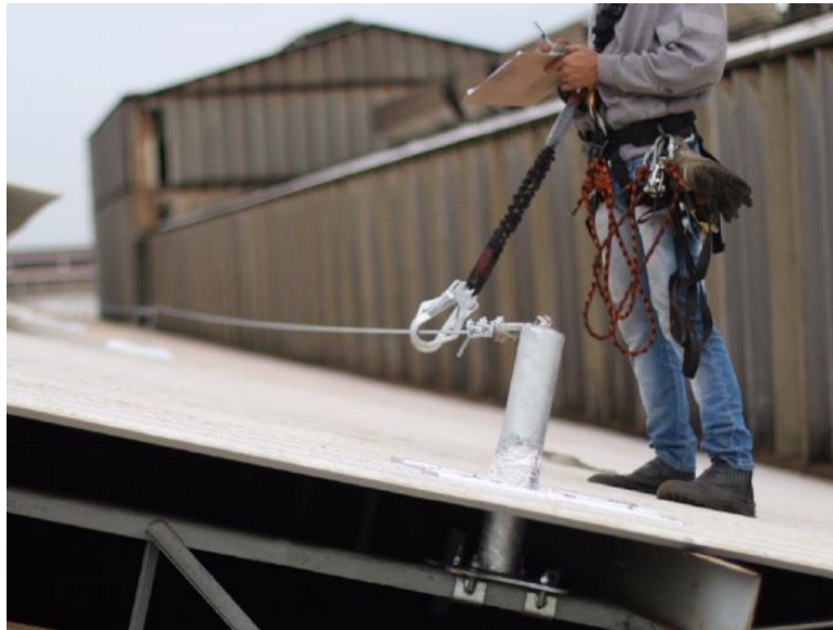
Figura 4- Ancoragem tipo C- linha horizontal
