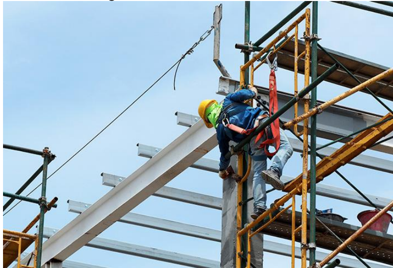
Figura 2- Trabalho em altura
