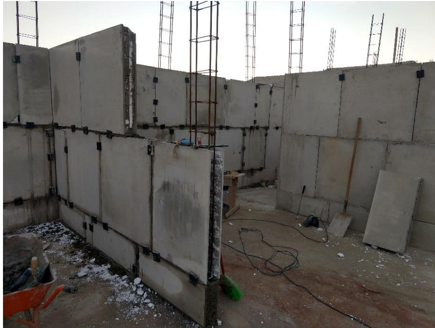
FIGURA 7-Processo de execução dos pilares
