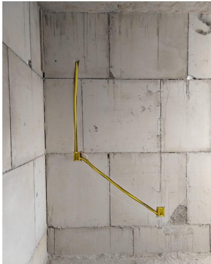
FIGURA 6- Tubulação elétrica embutida no Blocom
