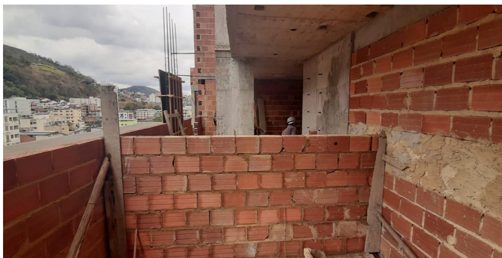
FIGURA 1- Edifício utilizando alvenaria de blocos cerâmicos
