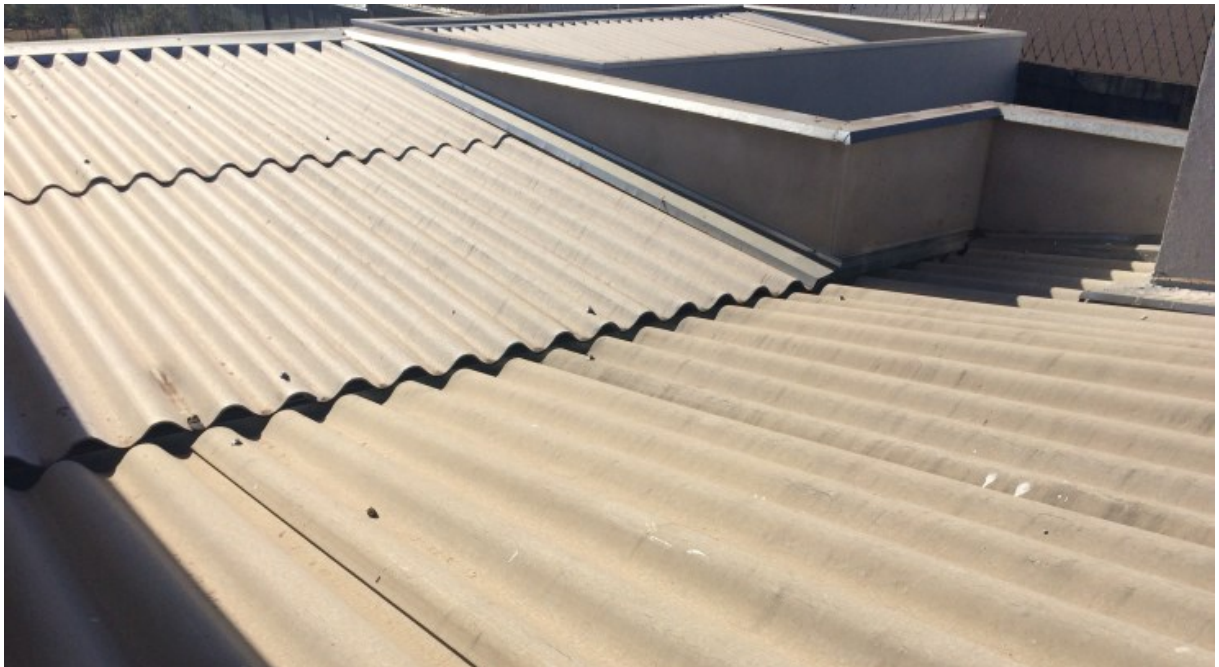
FIGURA 9 – Exemplo de Laje com cobertura em telha fibrocimento em residência.
