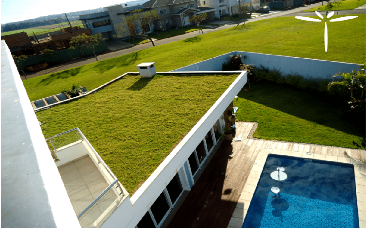
FIGURA 8 – Exemplo de laje pré-moldada com cobertura verde do tipo extensiva em residência.
