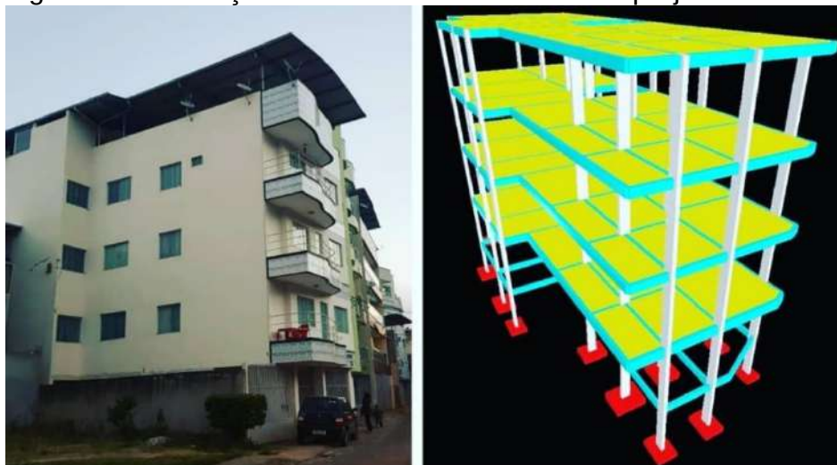
Figura 6 – Edificação construída e modelo 3D do projeto estrutural
