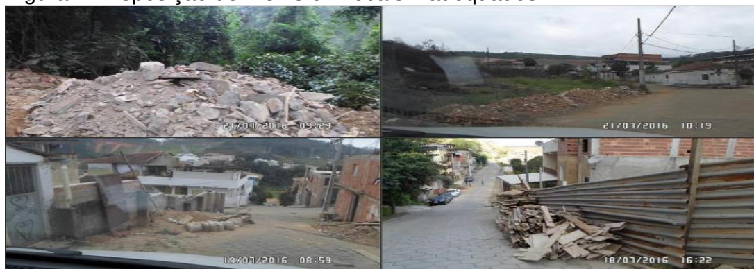
Figura 2: Disposição de RCDs em locais inadequados
