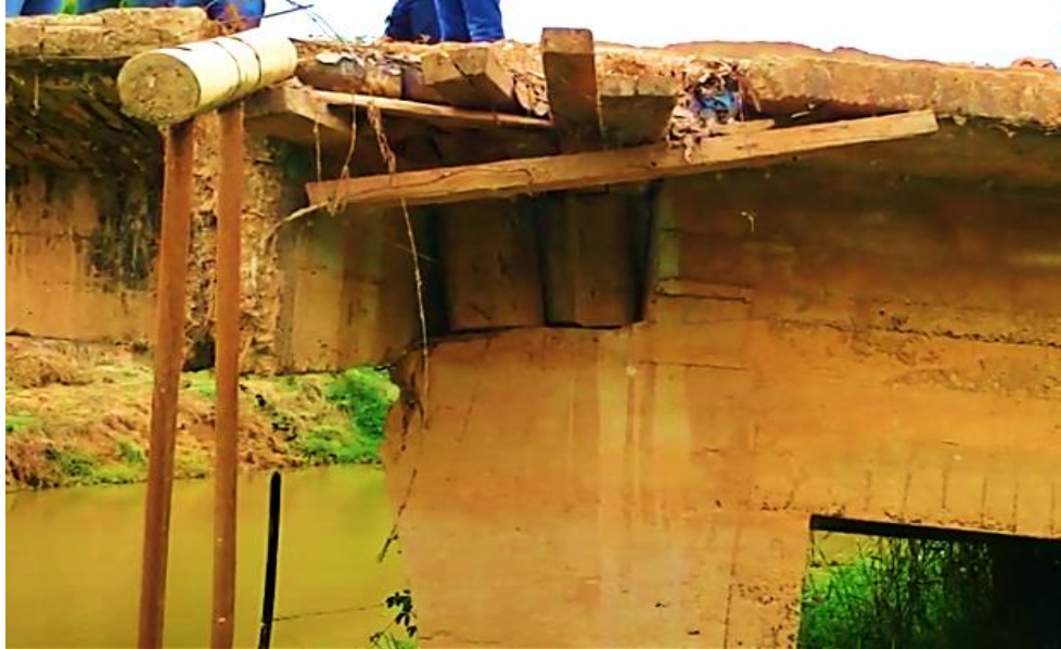
FIGURA 14 – Madeiras colocadas no apoio da ponte
