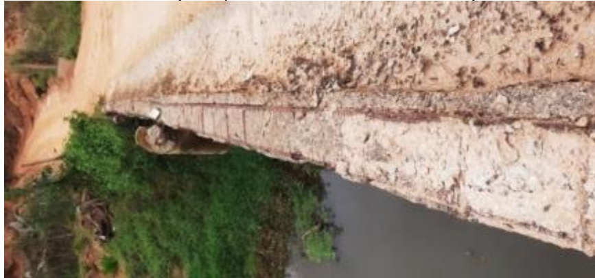
FIGURA 19 – Exposição de britas no tabuleiro por abrasão
