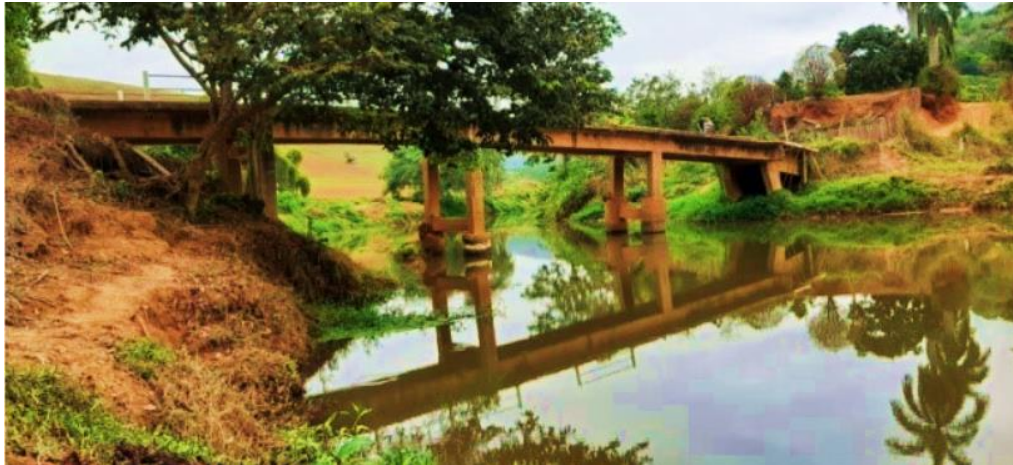
FIGURA 13 – Vista da Ponte do Barreiro
