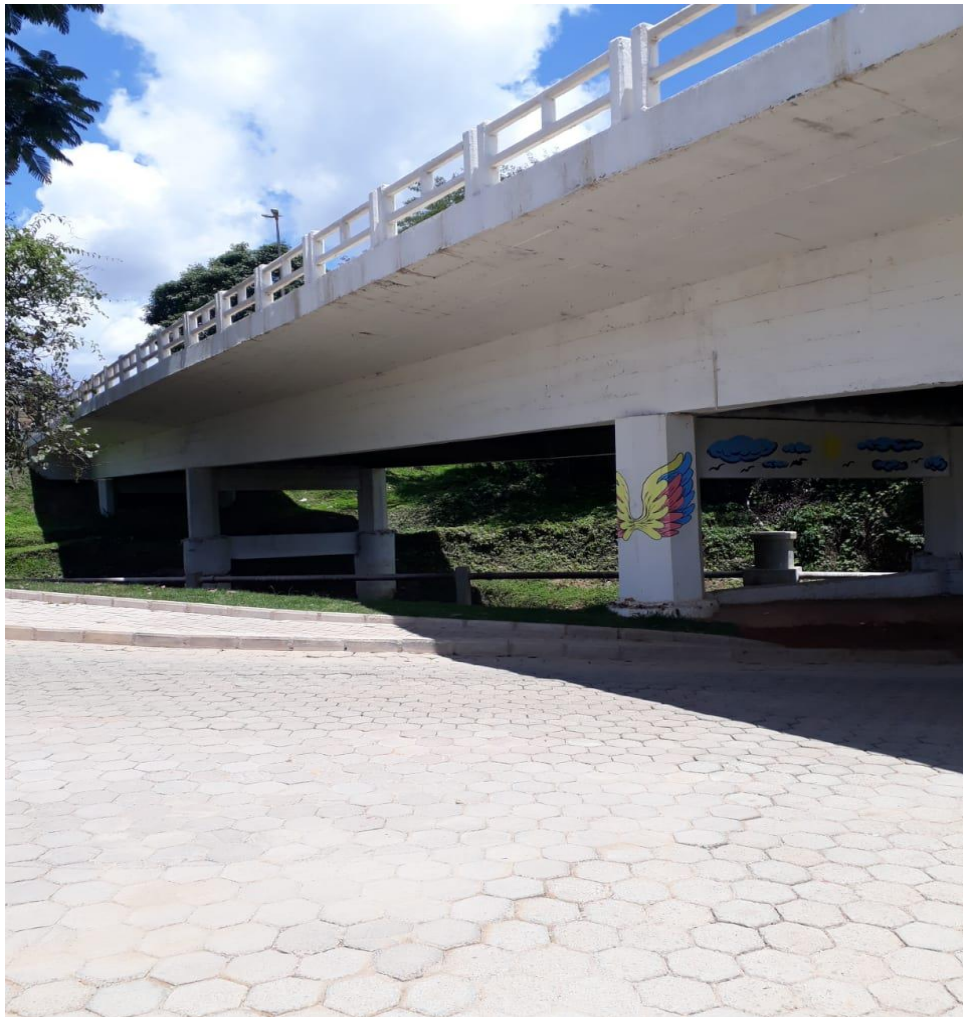
Figura 11: Estrutura: Ponte sobre o Rio Pardo em Ibatiba-ES
