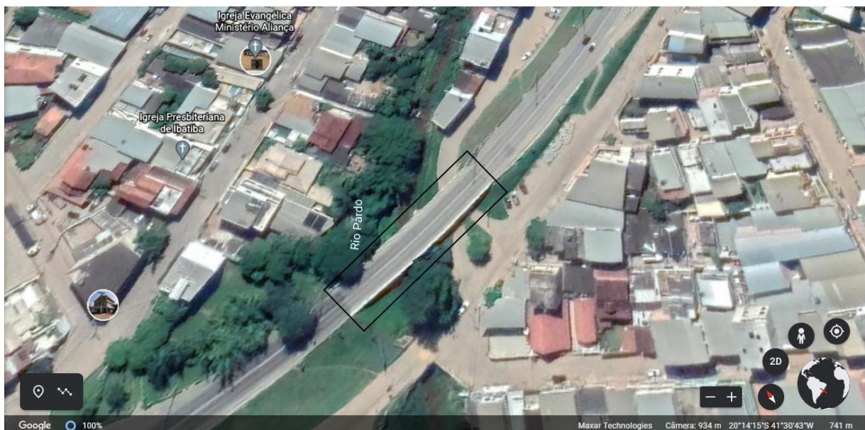
Figura 8: Vista superior: Ponte sobre o Rio Pardo em Ibatiba-ES
