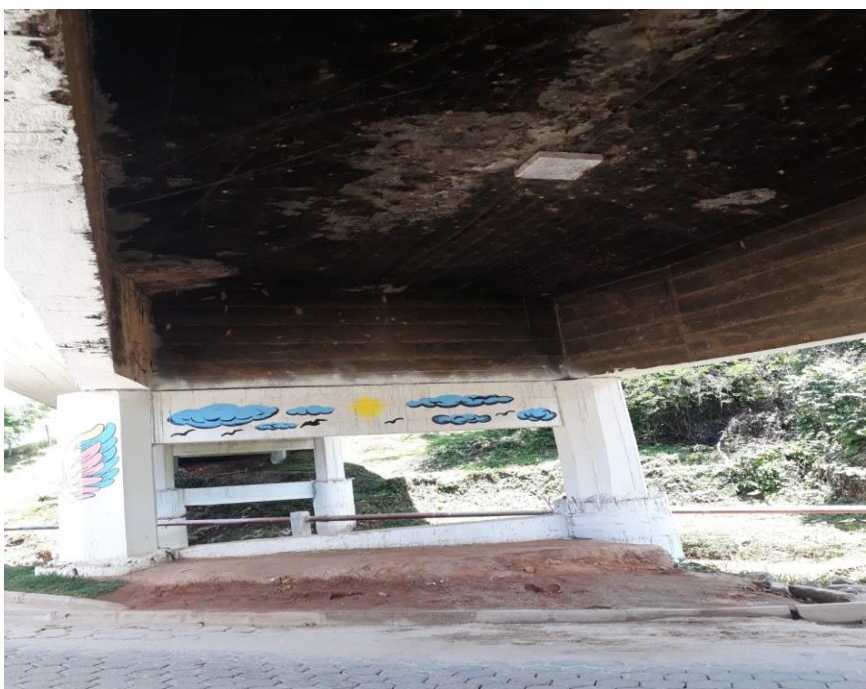
Figura 10: Estrutura: Ponte sobre o Rio Pardo em Ibatiba-ES
