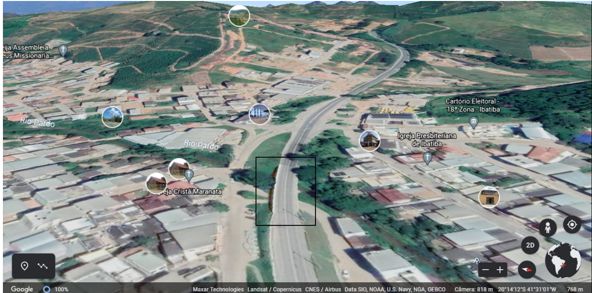
Figura 7: Vista frontal: Ponte sobre o Rio Pardo em Ibatiba-ES
