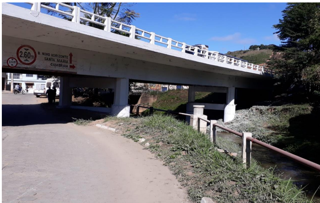
Figura 9: Estrutura: Ponte sobre o Rio Pardo em Ibatiba-ES
