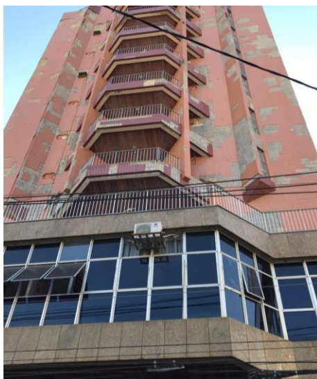
FIGURA 1 – Manhauçu Center Hotel, Manhauçu/MG.
