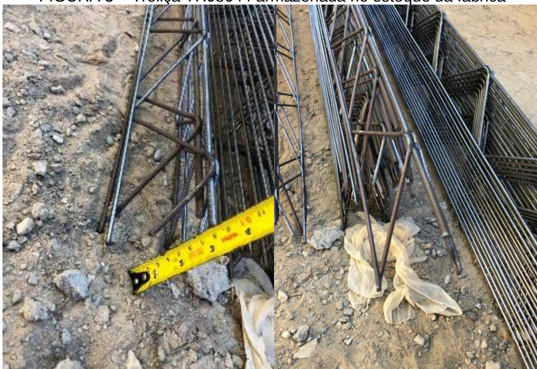
FIGURA 3 – Treliça TR08644 armazenada no estoque da fábrica
