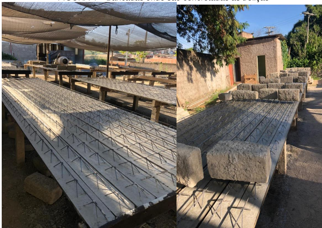
FIGURA 4 – Bancadas onde são concretadas as treliças
