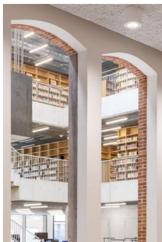
Figura 04: A antiga fachada no interior da nova edificação
