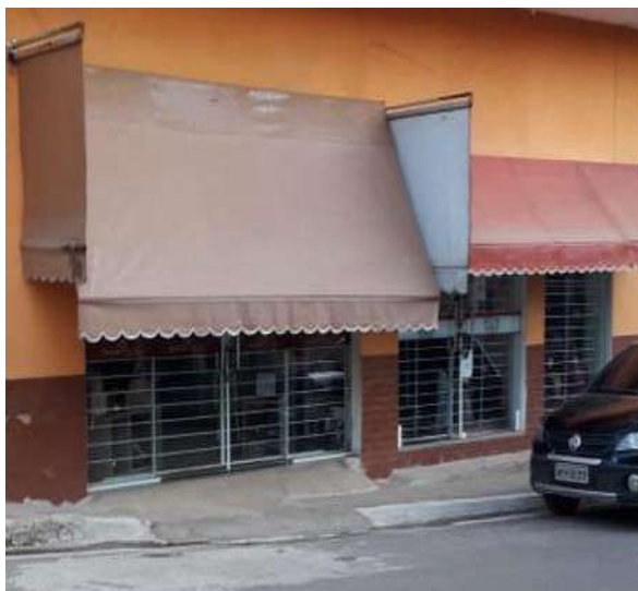
Figura 11 – Toldo obstruindo a passagem
