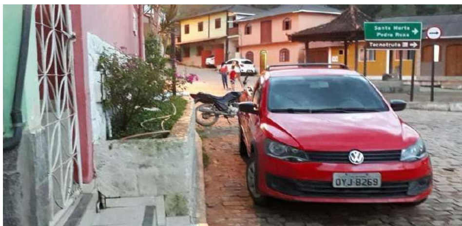
Figura 05 – Pça Oscar Vargas. Calçada inexistente - antigo centro da cidade
