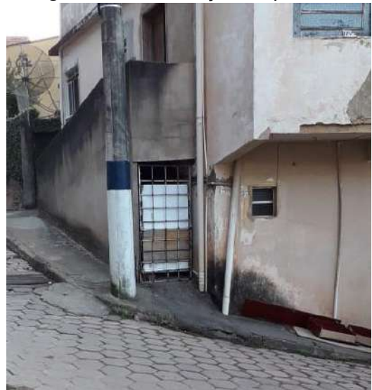
Figura 16 – Obstrução do passeio
