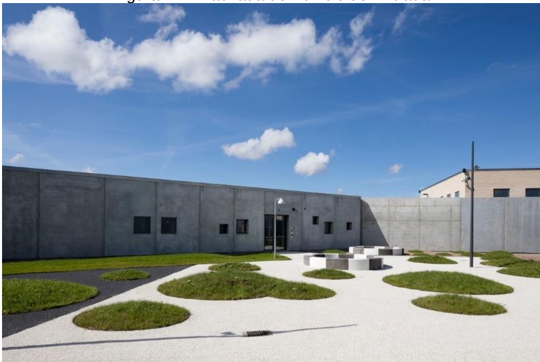
Figura 12 – Fachada do Edifício de Entrada.
