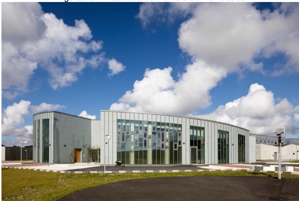
Figura 13 – Fachada do Edifício de Atividades.
