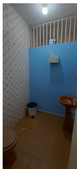
Figura 23 – Sanitário na ala das salas de aula
