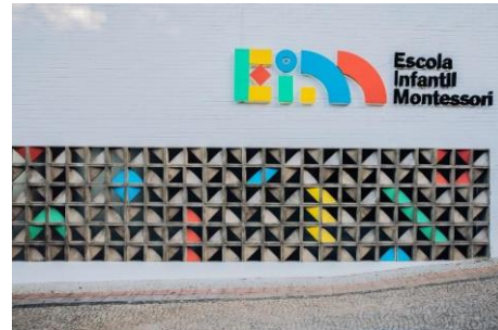
Figura 8 – Detalhe do Brise em Madeira e pintado nas cores Primárias e Secundárias
