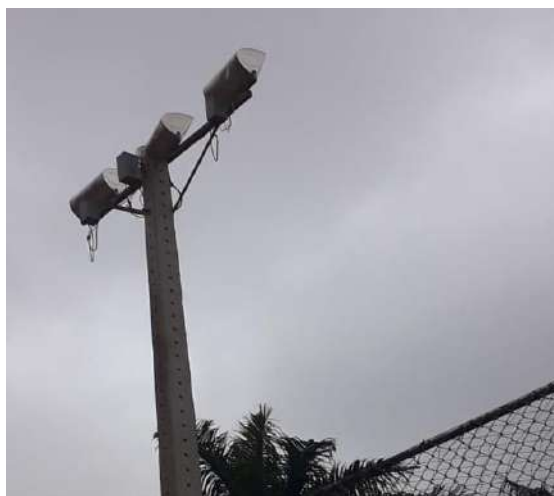
Figura 21 – Fios soltos na iluminação
