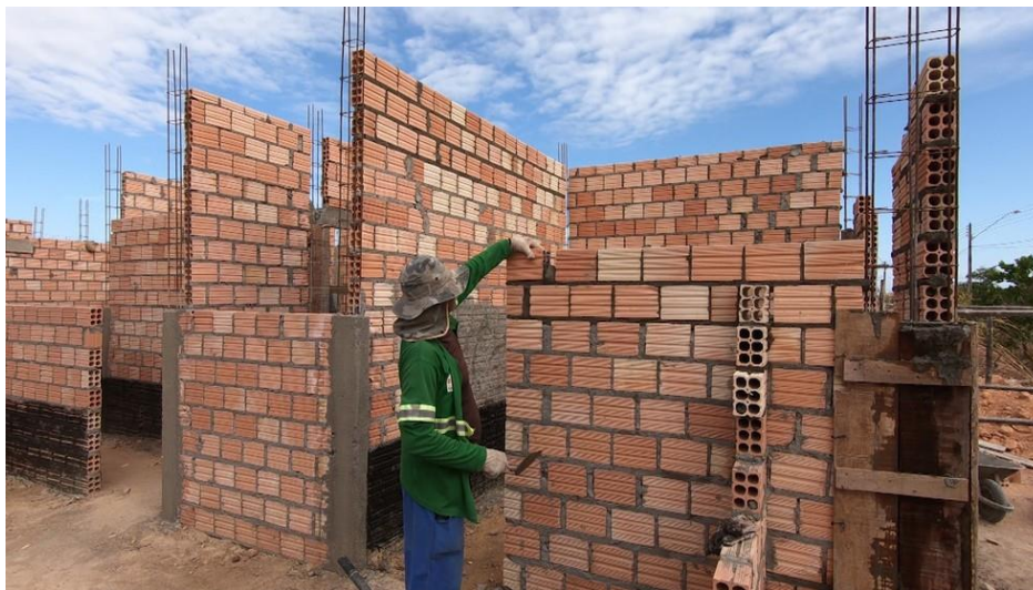
Figura 4: Edificação em alvenaria sendo executada.
