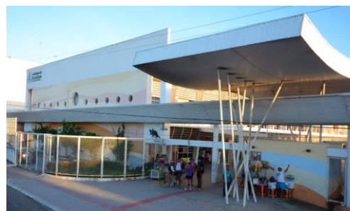
FIGURA 16 – Vista atual da fachada
