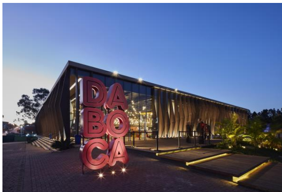
FIGURA 01 E 02 – Fachada Mercado da Boca.
