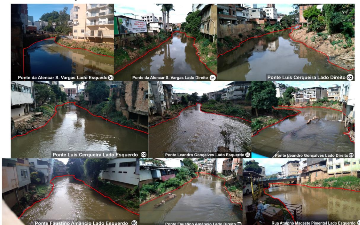
ILUSTRAÇÃO 03 – Marcação do Elemento Paisagístico e dos Elementos de Obstrução em Nível Um – Pontos 01, 02, 03, 06, 11, 12, 13 e 14.
