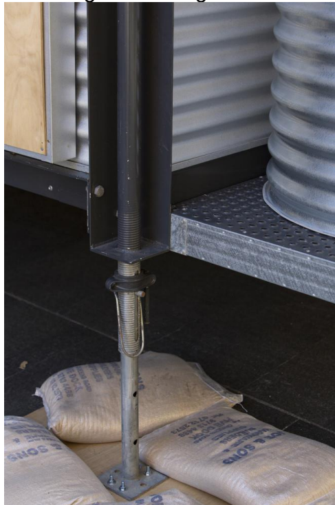
Figura 7- Pilar metálico abrigo de emergência Carter Williamson Architects
