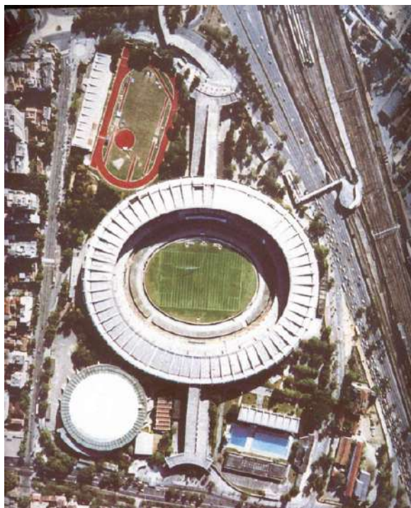
FIGURA 2 - Vista aérea do complexo esportivo antes da reforma para Copa do Mundo de 2014
