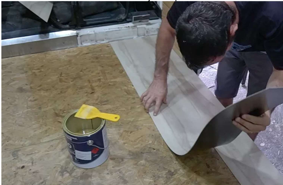
FIGURA 17 – Instalação do piso vinílico
