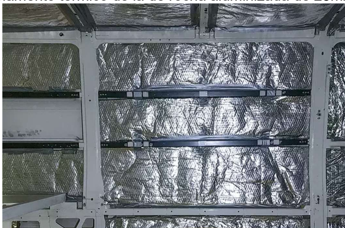
FIGURA 5 – Isolamento térmico de lã de rocha aluminizada de 25mm não inflamável
