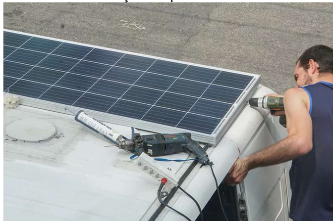
FIGURA 6 – Instalação do painel fotovoltaico de 150w
