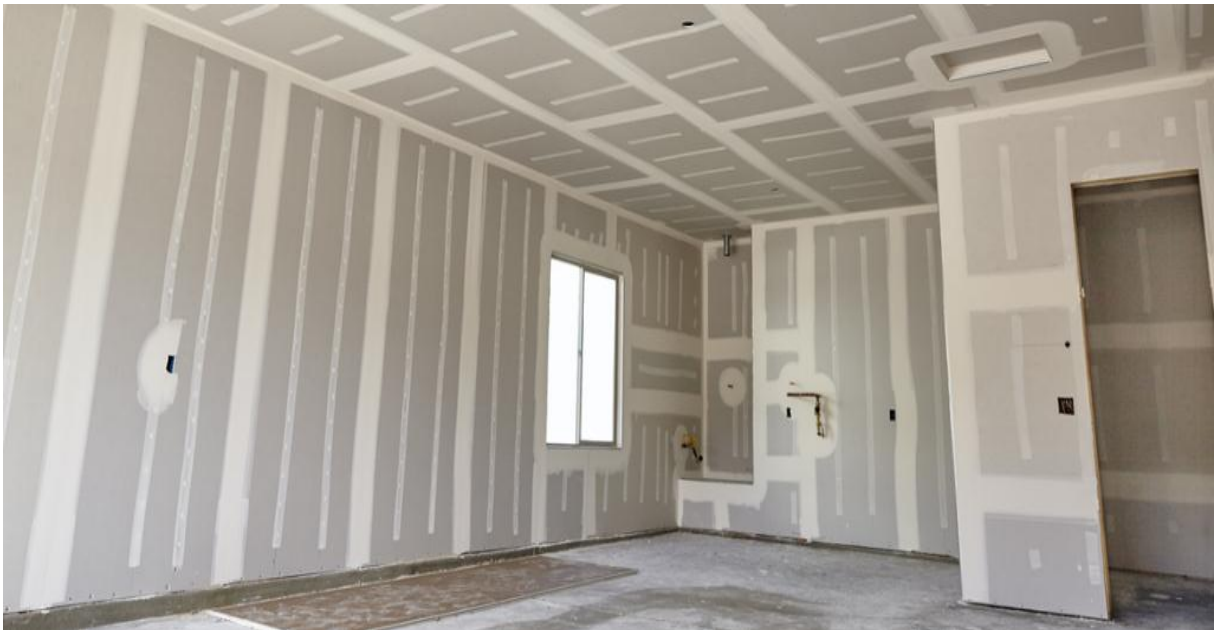
FIGURA 3 - Placas de Drywall instaladas
