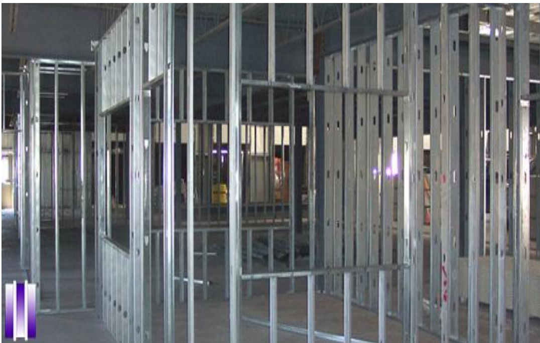
FIGURA 2 - Estrutura metálica de perfis para Drywall
