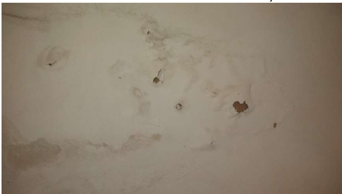
FIGURA 18 – Parede do Banheiro - edificação 2
